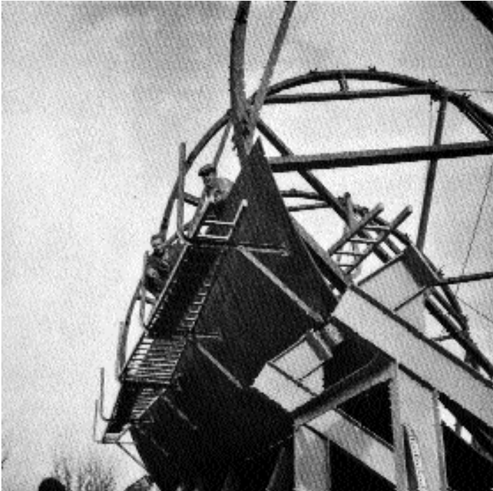
Equipo de fotógrafos de Gas del Estado de la Nación. Montaje del gasómetro a presión del Centro Floresta de la empresa Gas del Estado. Detalle de la ménsula para andamios, 1950 Colección Luis Prámo
